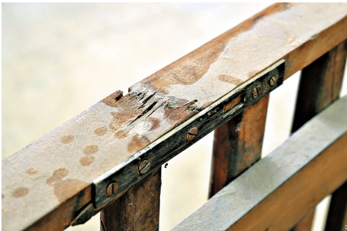
Estado de conservação de mobiliário, foram pericidas diversas formas de deterioração desde a infestação de cupins e outra pragas, até a ausência de componentes como pés de cadeira, entre outras avarias
