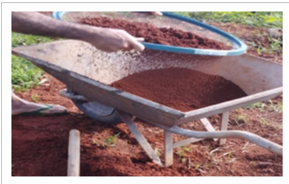
FIGURA 01 – Peneiramento do solo de escavação.
