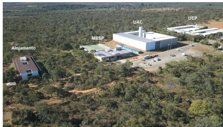
Figura 1: Edificações da FUP: Alojamento Dom Tomás Balduino; Módulo de Serviços e Equipamentos Esportivos (MESP), Edifício Paulo Freire (Unidade Acadêmica – UAC) e Unidade de Ensino e Pesquisa (UEP). Fonte: Couto Junior (2017).
